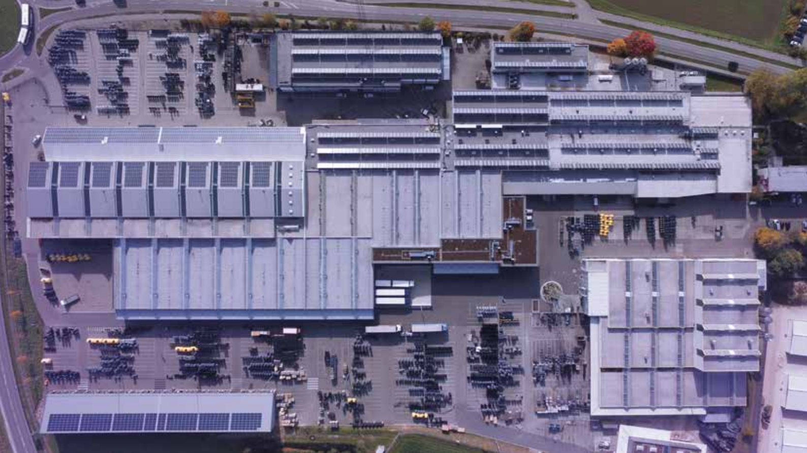
Instalações fabris da KESSEL, Lenting - Alemanha
