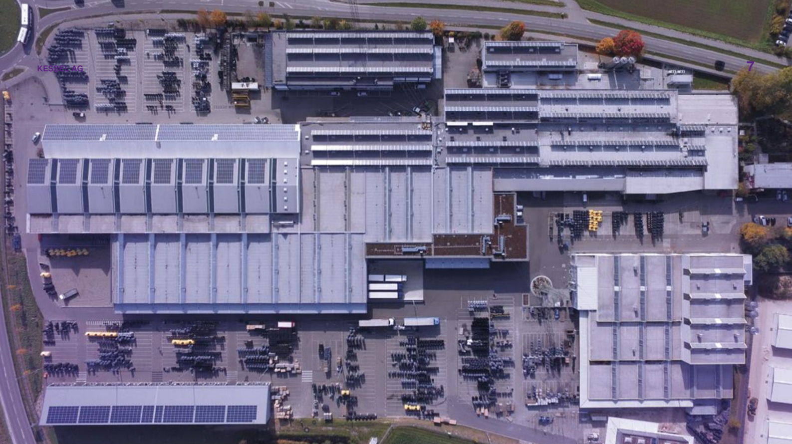
Sede da KESSEL Linting, Alemanha
