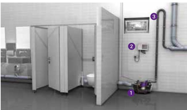
1 Estación elevadora 2 Unidad de control 3 Tubería de presión
